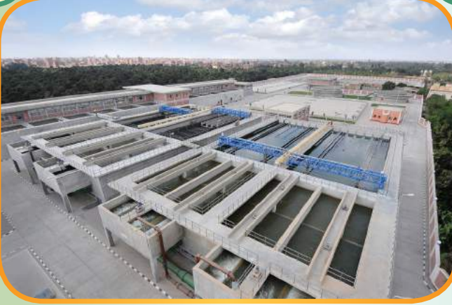
محطة مياه الشرب ببليس
